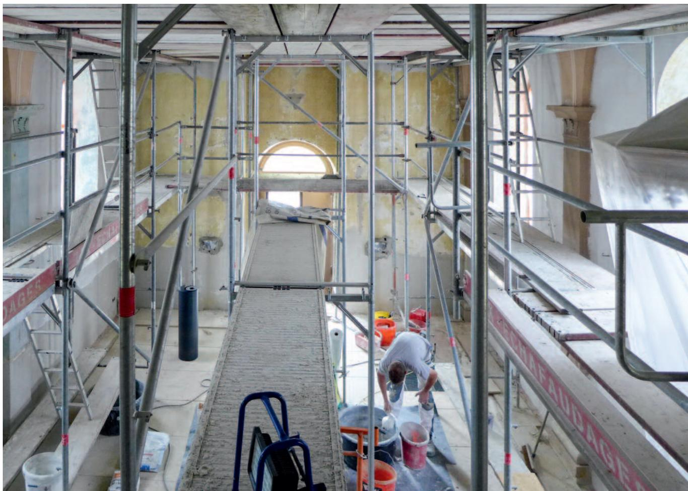
bringen konnte. Die hölzerne Tragstruktur und die Dachbinder wurden gesäubert und sorgfältig auf Schädlinge hin untersucht sowie mit einer Dämmung auf der Gewölbeoberseite versehen.
